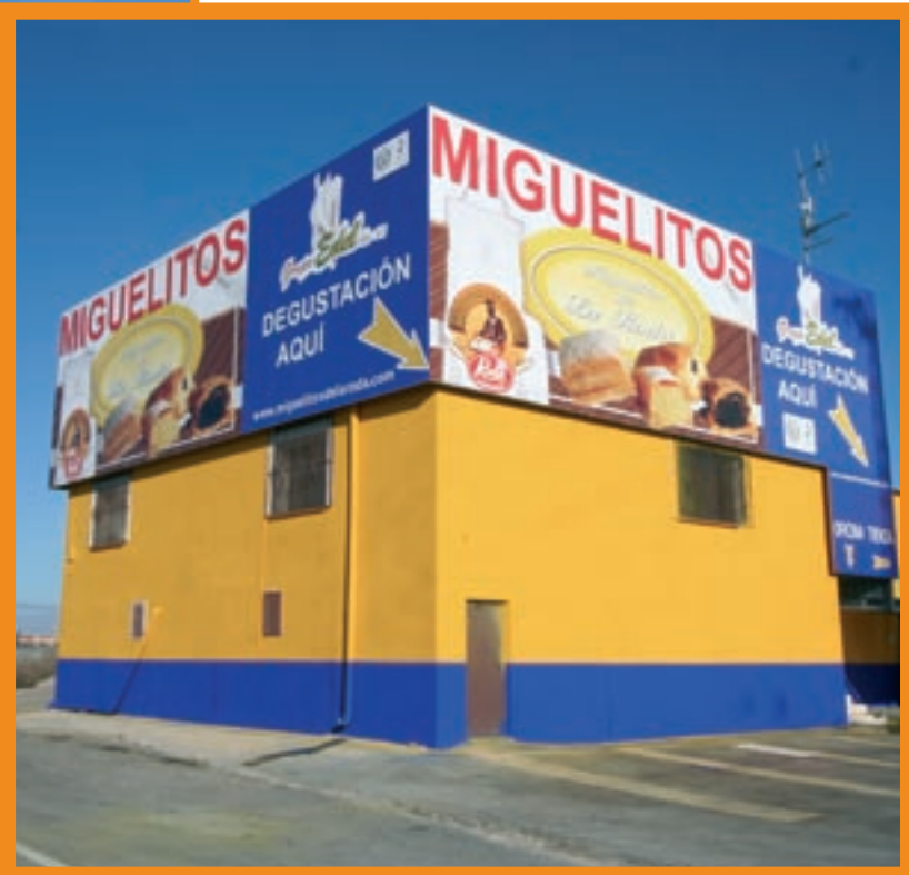
Revestimiento fachada 3 carteles de 12, 13 y 15 m de largo por 4 metros de altura
